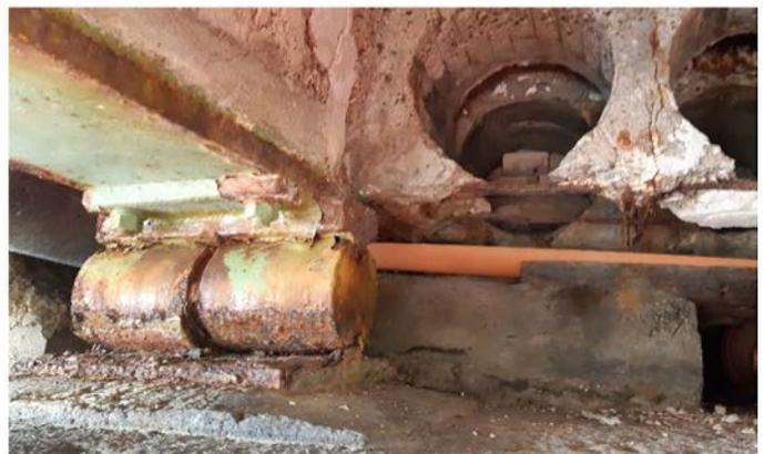
Um die Markusbrücke dauerhaft sicher nutzen zu können, ist es daher zwingend erforderlich, das Bauwerk zu sanieren. Das Maßnahmenpaket umfasst den kompletten Austausch der Auflagerkonstruktionen sowie der Übergangskonstruktion, Betonsanierungsarbeiten sowie die Erneuerung der Bleche an den Außenträgern.
